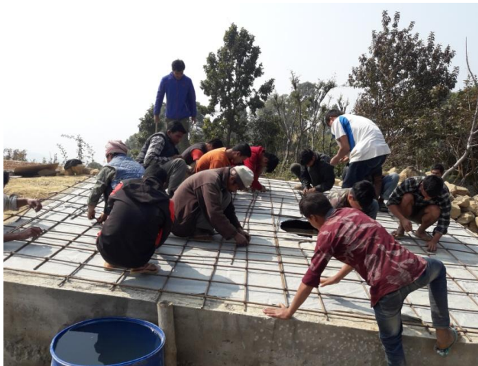
स्थानीय गाउँ पालिकाहरुसँगको स्रोत साभेदारीमा निर्माणाधिन खानेपानी टेंकी राप्ती, दाङ र कालिञ्चाक दोलखा
